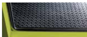
Suelo del contenedor con superficie de chapa metálica antideslizante
