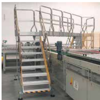
EM1105 Pasarela / Passadiço
